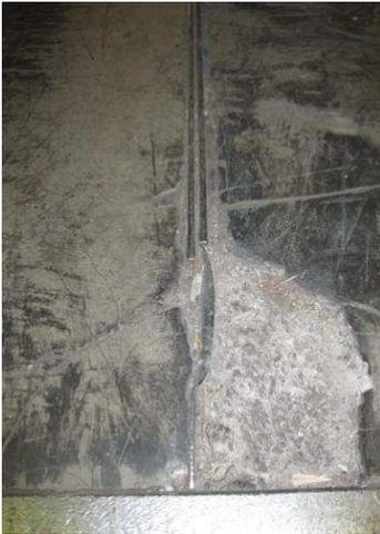
Völlig deformiertes Fugenprofil mit hohem Gefährdungspotential!
